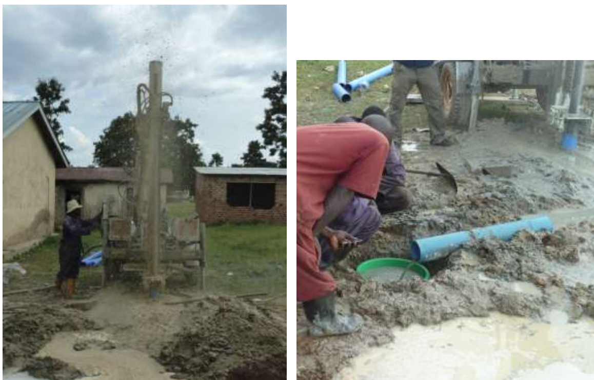
Figuur 7: Uitkomend water bij schoonpompen van de borehole en debietmeting
