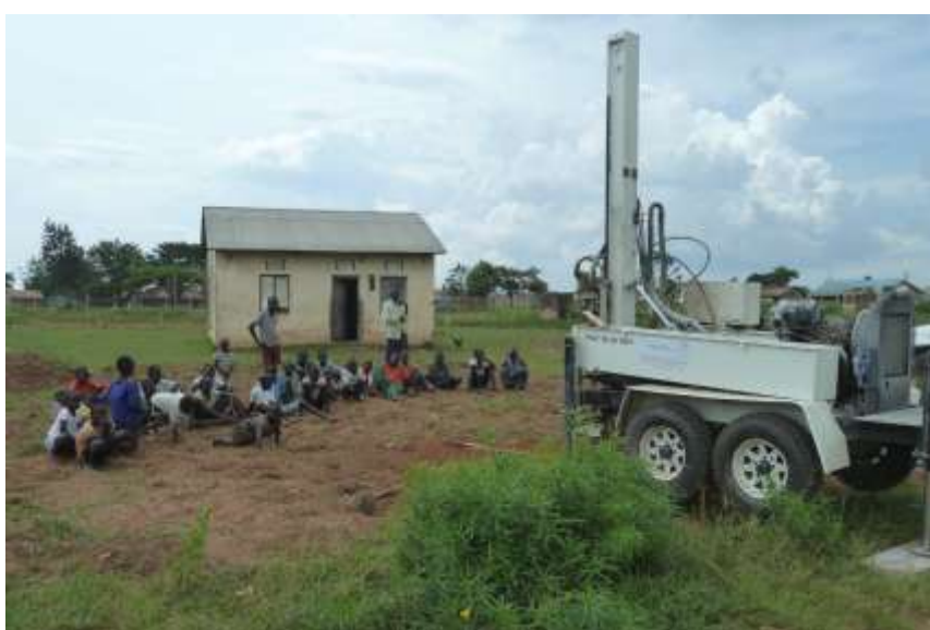
Figuur 8: Locatie 2 e borehole ter plaatse van WIG-3
