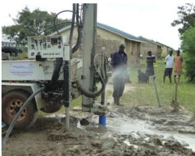
Figuur 6: Opbouw uitkomend boomateriaal en start boring hardrock
