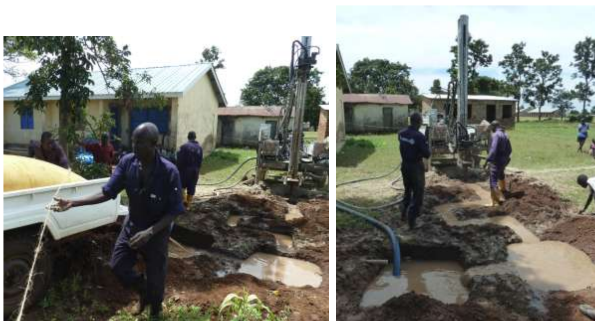
Figuur 5: Aanvoer water naar mudpit en overzicht booropstelling
